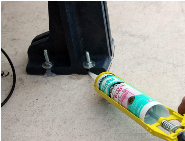
Se aplica silicon sobre el tornillo para sellar perfectamente
