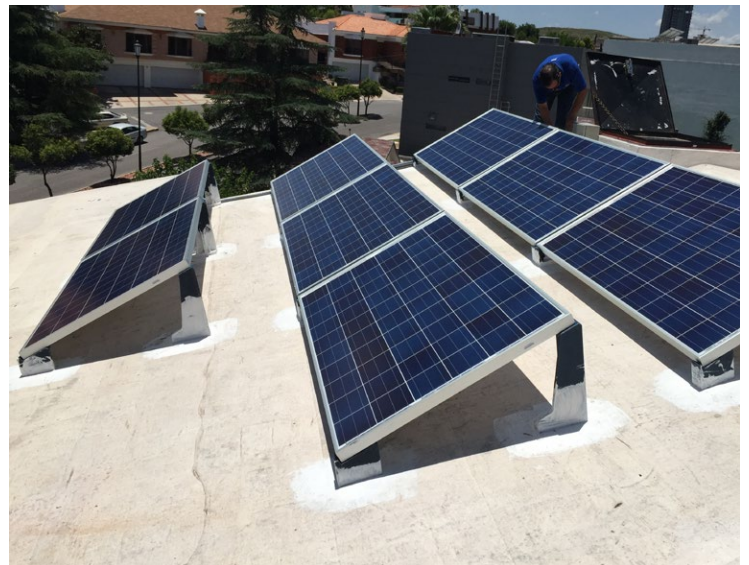
Posteriormente se aplica impermeabilizante .
